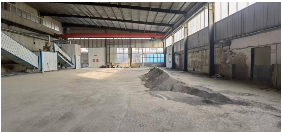
本项目车间现状
