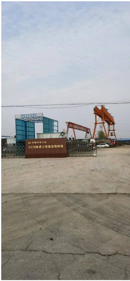
北侧 S229 改建工程箱梁预制场
