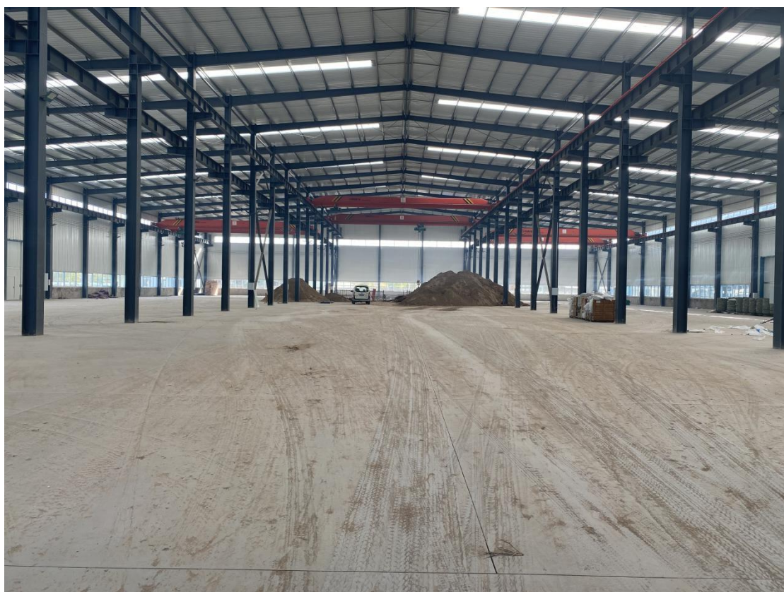
本项目生产车间
