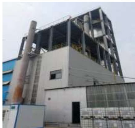
现有工程喷雾干燥装置
