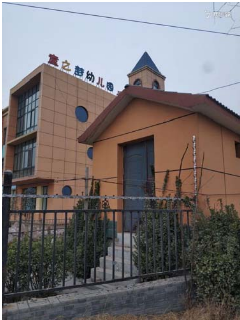
合河社区污水处理站
